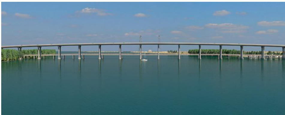
El puente Clarence River Crossing, construido por Ferrovial y Acciona. (Ferrovial)
